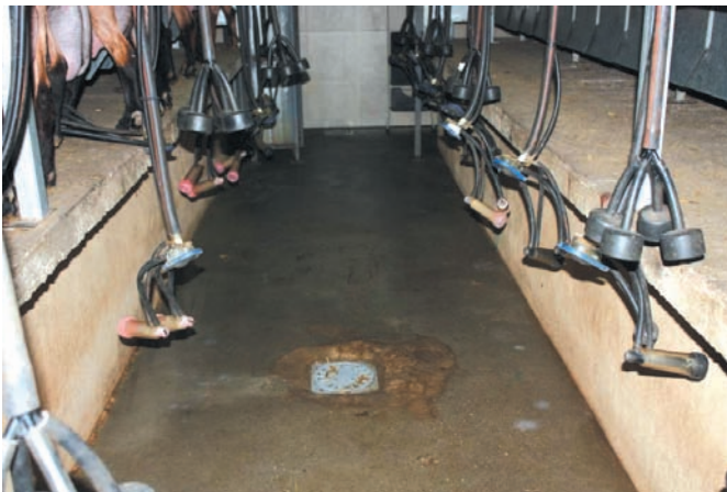
SALA DE ORDEÑO. ELIMINACIÓN DE LÍQUIDOS
