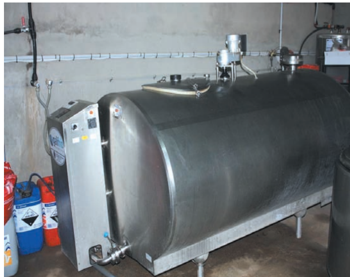
TANQUES Y SISTEMA DE REFRIGERACIÓN
