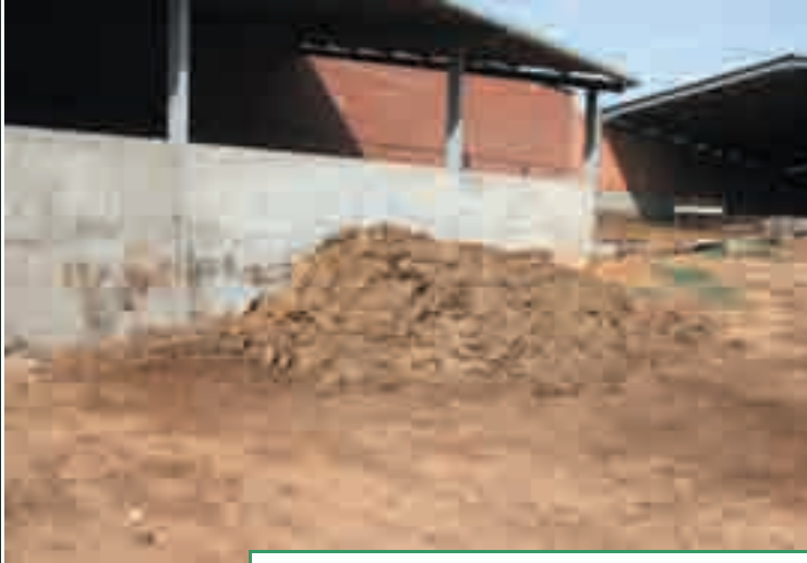
ESTERCOLERO, CON CAPACIDAD PARA ACUMULAR VARIOS MESES DE ESTIÉRCOL SÓLIDO
