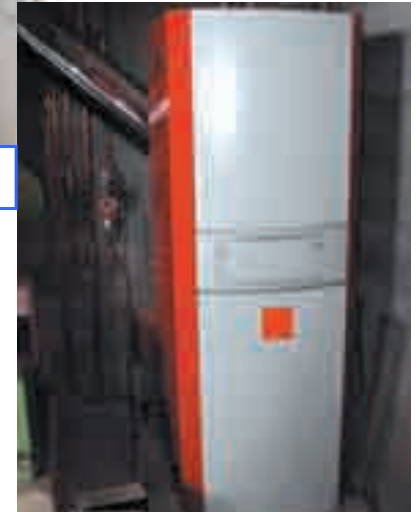
CALDERA DE AGUA CALIENTE
